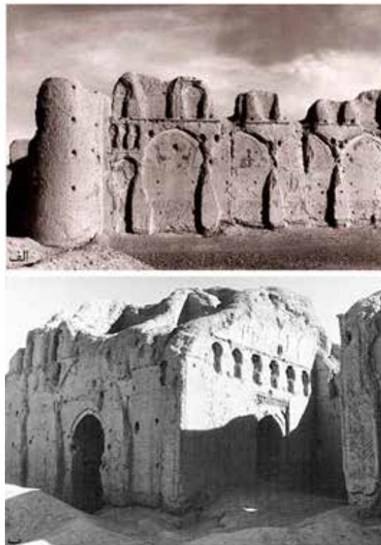
شکل ۵. دو نما از درون و بیرون کاخ جنوبی؛ الف) نمایی از گوشه‌ی جنوب شرقی کاخ و تاق‌نماهای آن؛ ب) نمایی از صفه‌ی شرقی میانسرا و تاق‌نماها و دندان‌موشی‌های پیشانی یکی از درگاه‌های آن (مأخذ: https://archnet.org/sites/3922/media_contents/41960 )
