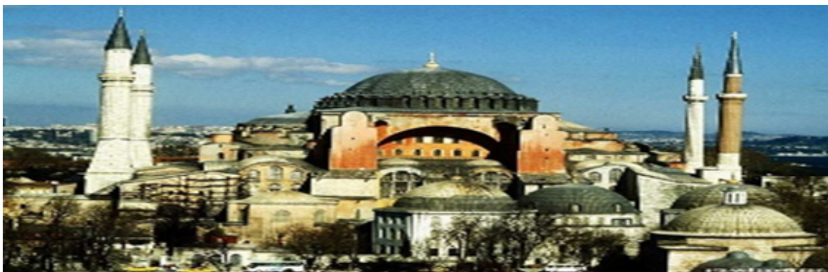
تصویر ۱۵. مسجد ایاصوفیه در ترکیه
