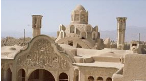
تصویر ۱. نمای تاج خانه بروجردی و نقوش گچبری آن. منبع: آرشیو اسناد پایگاه میراث فرهنگی شهرستان کاشان.
